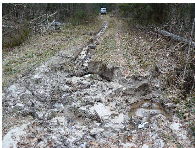
Рис. 3.1. Промоина на дороге.
